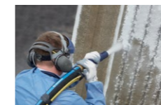
8,6 tot 10 bar: Schuurstralen
