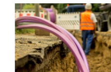
12 bar: Kabelblazen en boren
